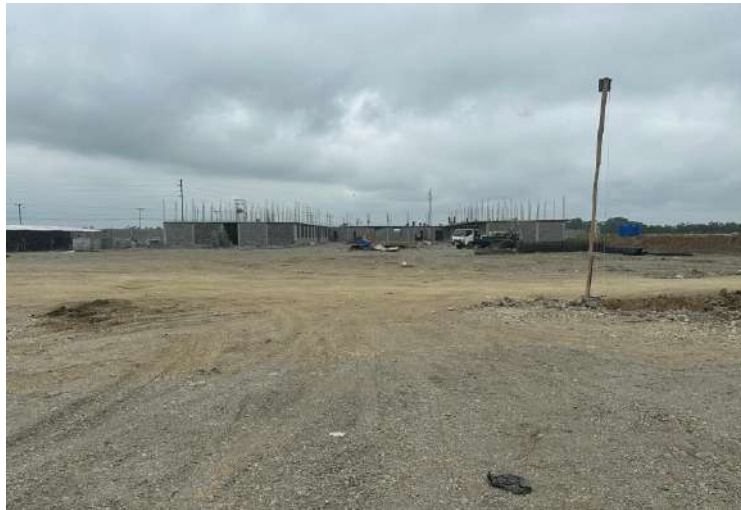
Ilustración 6: Construcción de edificaciones industriales Fuente: Equipo Consultor
