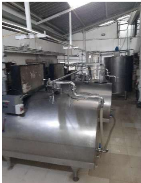
FOTOGRAFÍA 7 ENFRIAMIENTO Y TERMINACIÓN FUENTE: EQUIPO CONSULTOR
