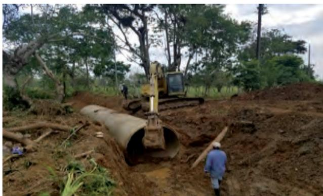
Colocación en zanja, tubo de fibra de vidrio diámetro 2m.
