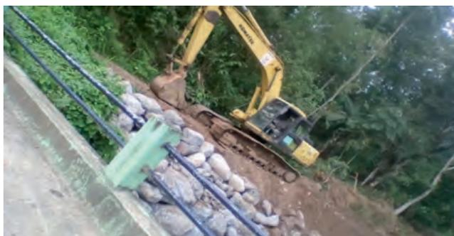
Colocación de piedra de escollera margen derecho aguas arriba del puente nuevo construido por el GAD de la Provincia del Cañar.
